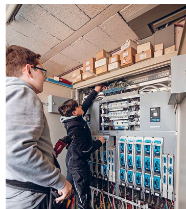
Instandstellung und Optimierung der Elektroinstallation auf dem Berg...
